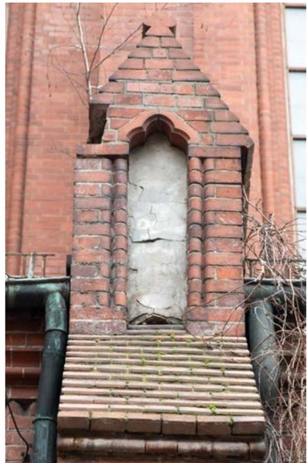
gereinigt. Das Gebäude muss zur Entfernung der zu harten, stark zementhaltigen Fugenmassen zum größeren Teil entfugt werden, da in diesen Fugen eine Hauptursache der Mauerwerksschäden liegt. Intakte Abschnitte des Fugenetzes können bestehen bleiben. Schadhafte und formal unpassende Ziegel werden ausgebaut und durch neue oder aus dem Rückbau gewonnene Steine ersetzt.
